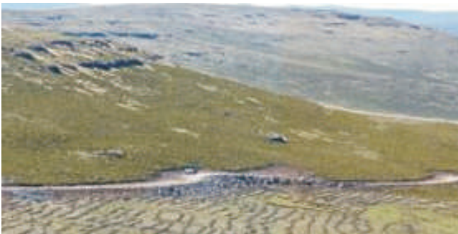
Débroussaillage et terrassement
